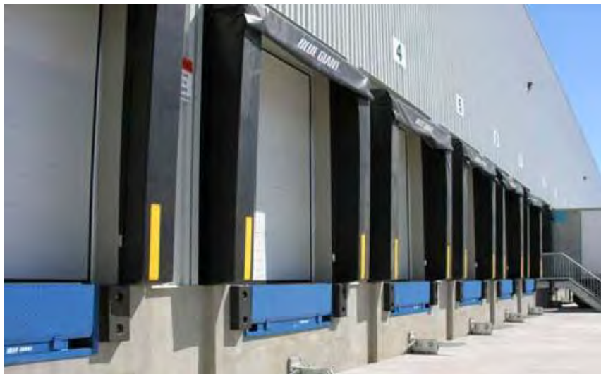
Slika 6.6 Pretovarna platforma teretnog terminala
